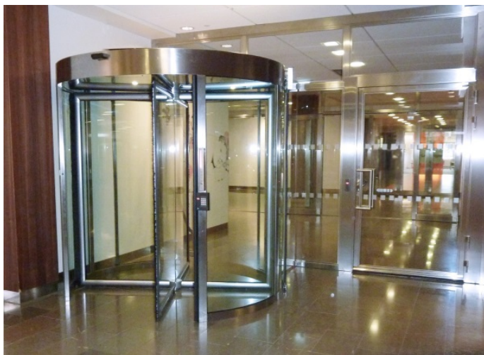
Porta rotante UNIVERS AC Maxi con lettore di badge esterno UNIVERS AC Maxi revolving door with external badge reader
