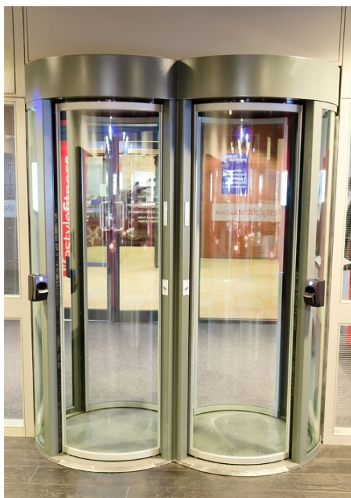
In alto: dettaglio del lettore biometrico per il controllo accessi in ingresso e in uscita dalla palestra
